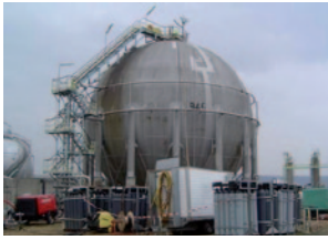
1 Mesures d'épaisseur de la paroi sur une cuve de stockage
