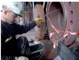
1 Observation par vidéoscopie de l'intérieur d'un cylindre afin de déceler la présence d'éventuelles fissures
